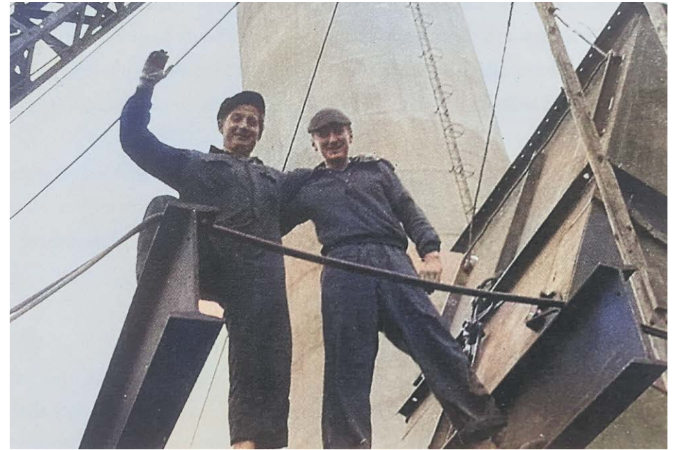
ZWEI ARBEITER AUF MONTAGE, GROSSRÄSCHEN 1959 (KOLORIERT)
